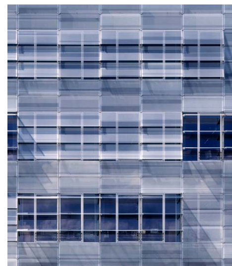
Ovenfor // Facadedetalje fra Sparekassen Kronjylland tegnet af 3XN og opført i 2002. Byggeriet modtog Randers Kommunes Arkitekturpris i 2003. Fotograf Adam Mørk.
